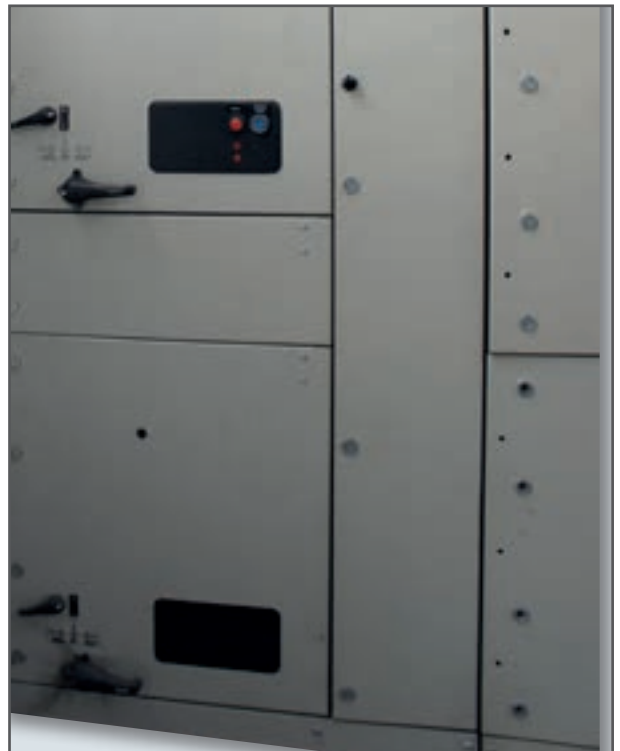
Arco interno PMCC
