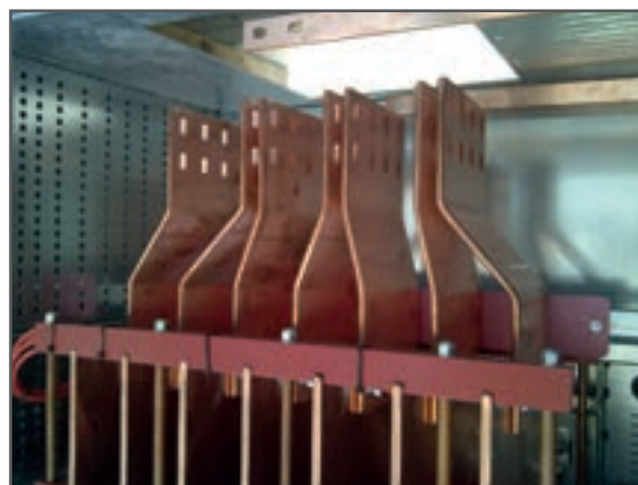
Predisposizione per collegamento terminale blindosbarra Arrangement for busduct terminal connection Prédisposition pour liaison terminal omnibus
