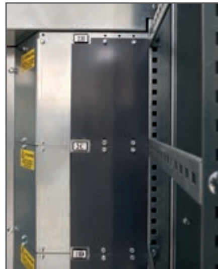
Particolare uscita cavi forma 4b
