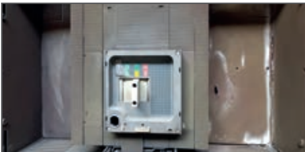
Dettaglio dopo test tenuta arco interno
