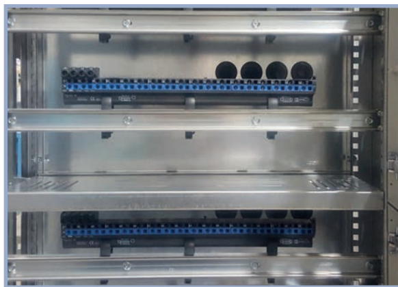
Esempio Forma 2A - Example Form 2A - Exemple Forme 2A
