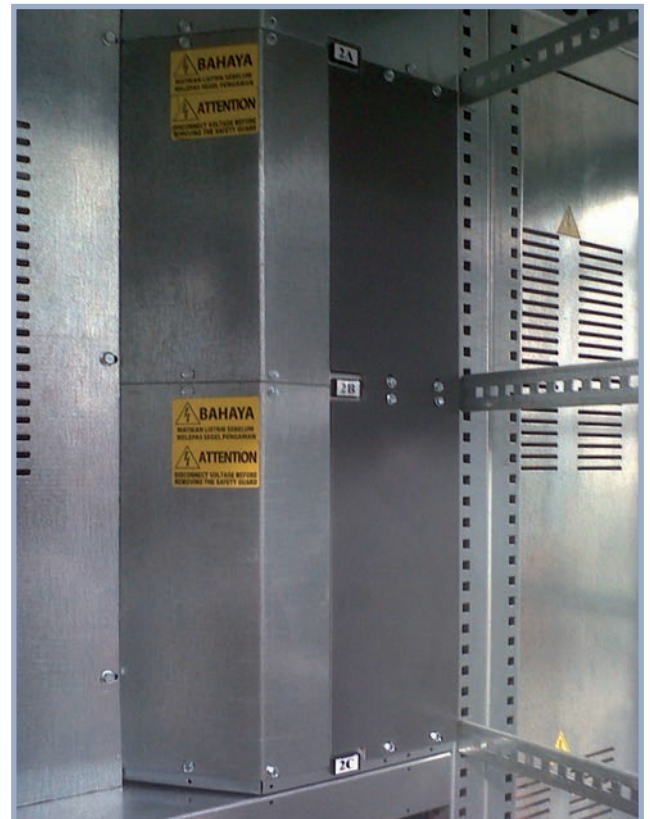
Esempio Forma 4B - Example Form 4B - Exemple Forme 4B
