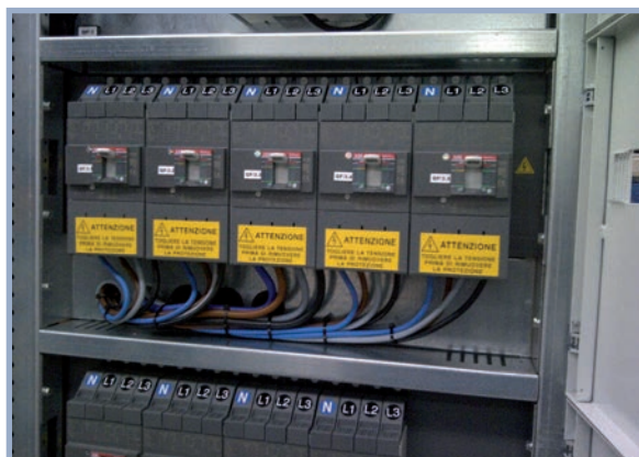
Esempio Forma 2B - Example Form 2B - Exemple Forme 2B
